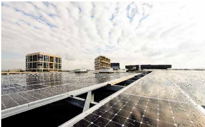
Panneaux Photovoltaïques en toiture de l'actif Enjoy à Paris 17 e .
